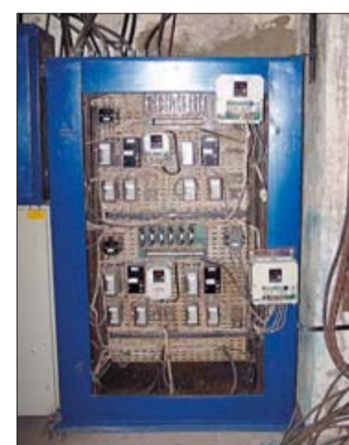
Электроцит управления насосами подачи теплоносителя с преобразователями EI-8001
