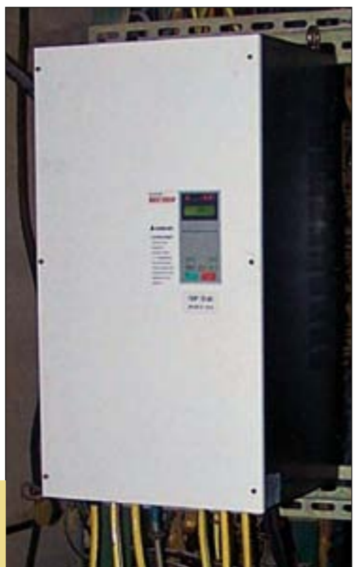
Мешалка, занимающая несколько этажей Преобразователь частоты EI-7011 привода мешалки мощностью 55 кВт
