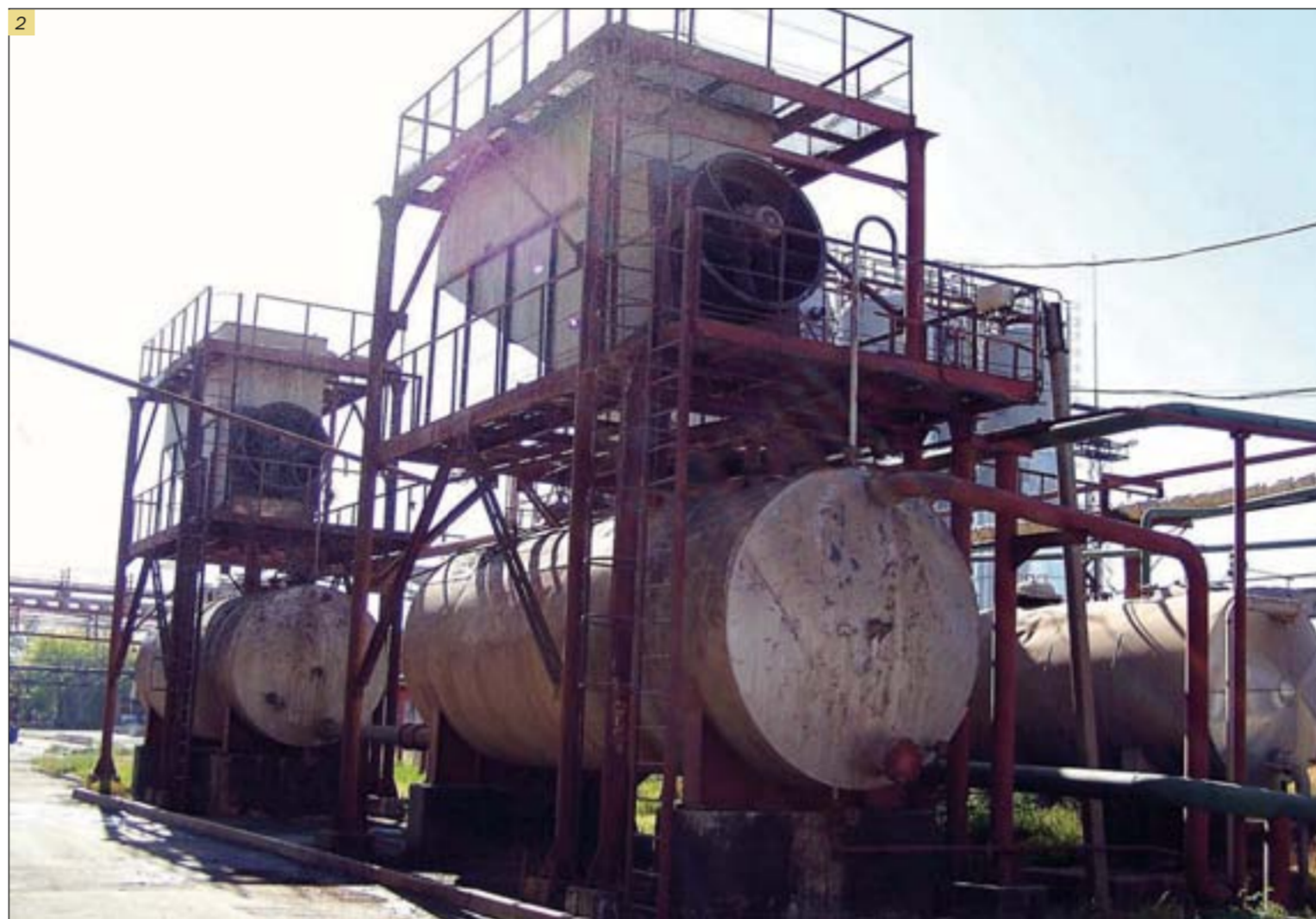
1. Инженер конструктор ОГК Вахрамеев Александр Владимирович. 2. Градирня цеха изготовления топливных добавок. 3. Приводом дутьевых вентиляторов управляют преобразователи частоты. 4. Центральный пульт управления цеха приготовления топливных добавок. На переднем плане слева направо заместитель начальника цеха по технологии Андрианов Руслан Владимирович, начальник участка электроцеха Рыков Виктор Витальевич
