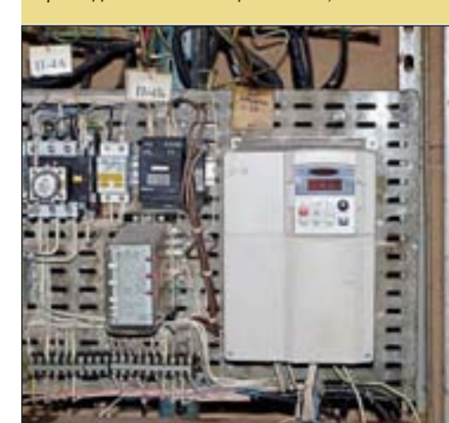
Преобразователь частоты E2-8300 привода шнеков мощностью 5,5 кВт
